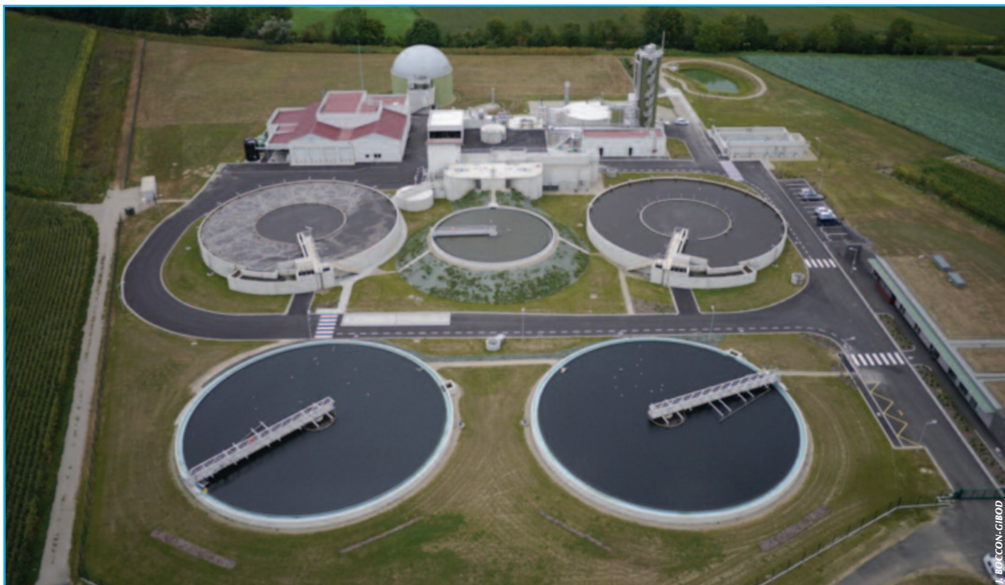
Vue aérienne de la station d'épuration de l'Ehn
