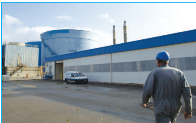
L'installation de traitement d'eau occupe la totalité du bâtiment ci-dessus
