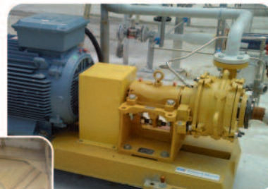
EMW-M : Pompe blindée métallique
