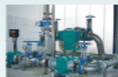
Le Multichopper Börger est un broyeur à grille et à couteaux. Les 3 couteaux assurent une coupe totale à chaque rotation.
