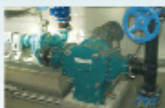
Le Multichopper Börger est un broyeur à grille et à couteaux. Les 3 couteaux assurent une coupe totale à chaque rotation.
