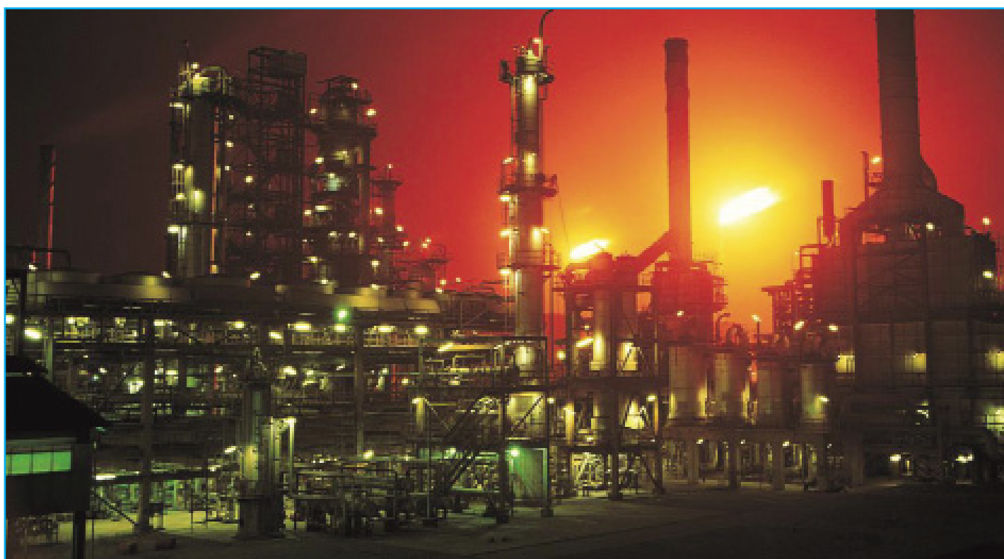
Les installations de pétrochimie sont particulièrement concernées par le PMI (plan de modernisation des installations) mis en place par l'état en 2010.
