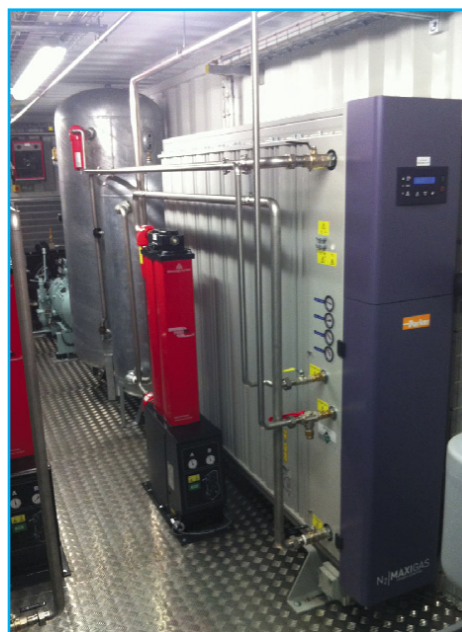
Vue intérieure du container
