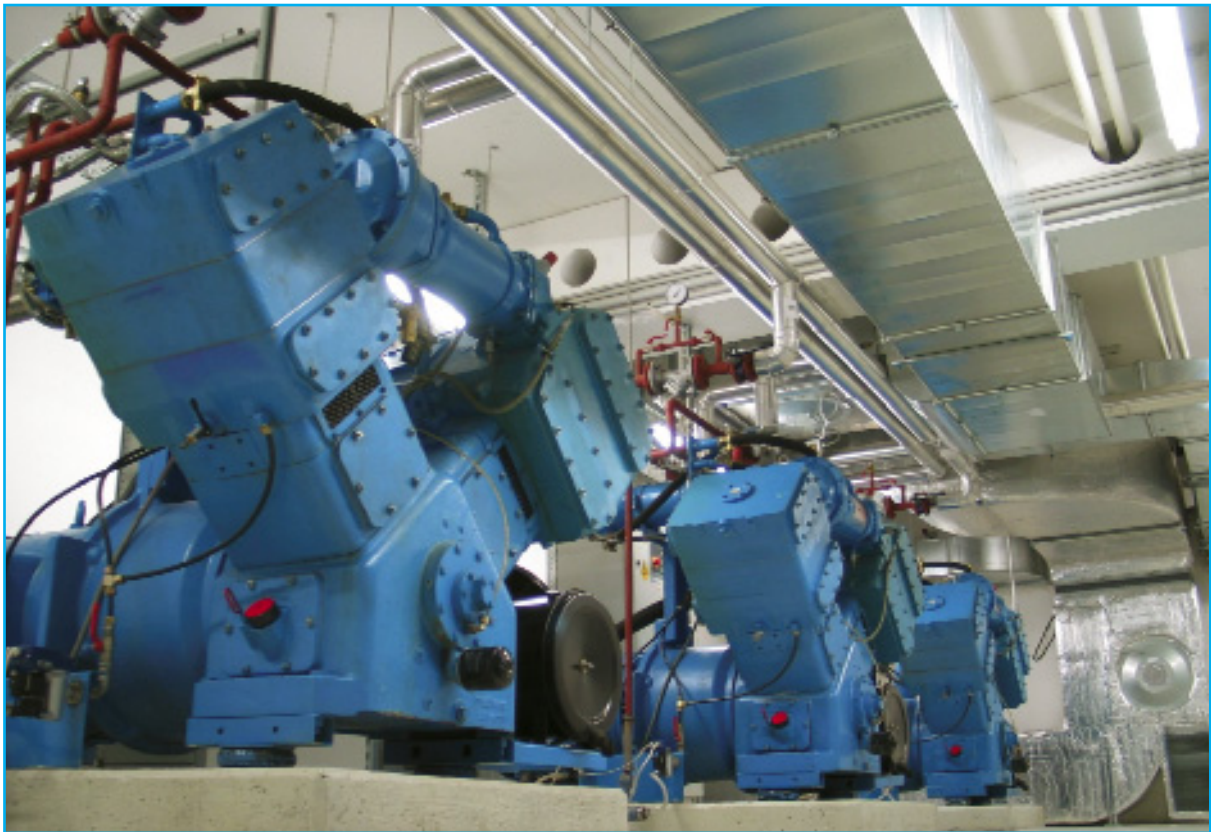
Les CHAMPIONS : ces compresseurs à pistons sans huile offrent des rendements énergétiques exceptionnels.
