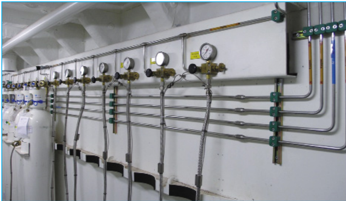
Exemple d'installation pour distribution d'oxygène
