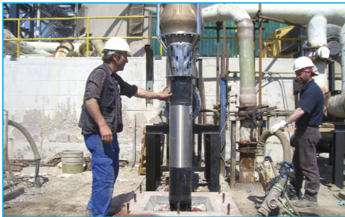
Pompe immergée en cours d'installation
