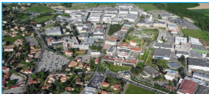
Le site Sanofi de Marcy l'Etoile dispose d'un immense réseau d'eaux
