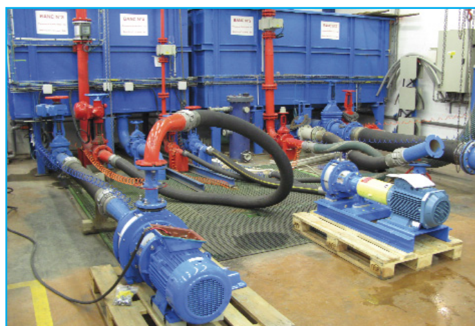
Après assemblage, toutes les pompes sont testées.
