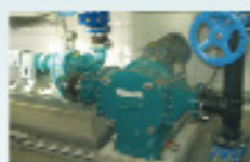
Le Multichopper Broyeur est un broyeur à grille et à couteaux. Les 3 couteaux assurent une coupe idéale à chaque rotation.
