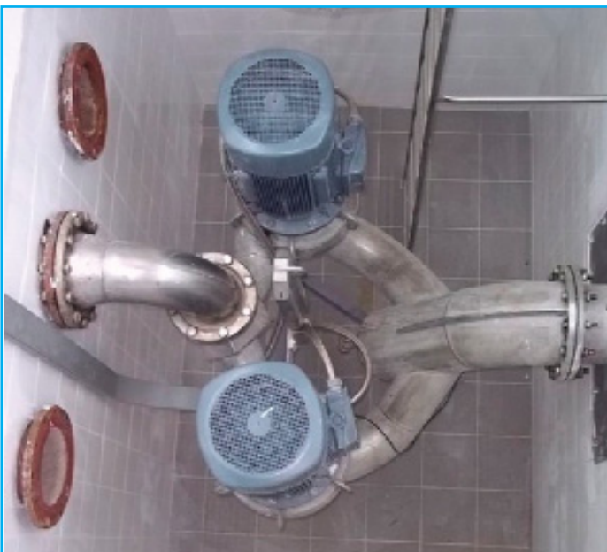
Réhabilitation d'un poste immergé
