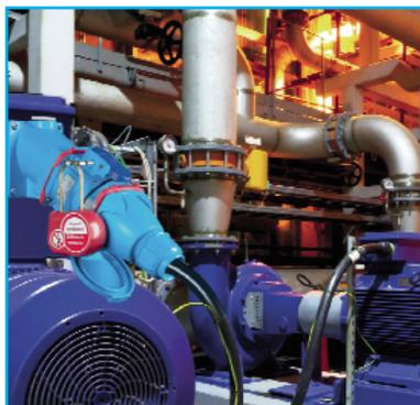
Des avantages certains : pour la sécurité des utilisateurs, condamnation mécanique des prises. Gains de temps et optimisation des coûts grâce au DECONTACTOR™, intégration de contacts auxiliaires, 24 positions de détrompage, versions ATEX,...
