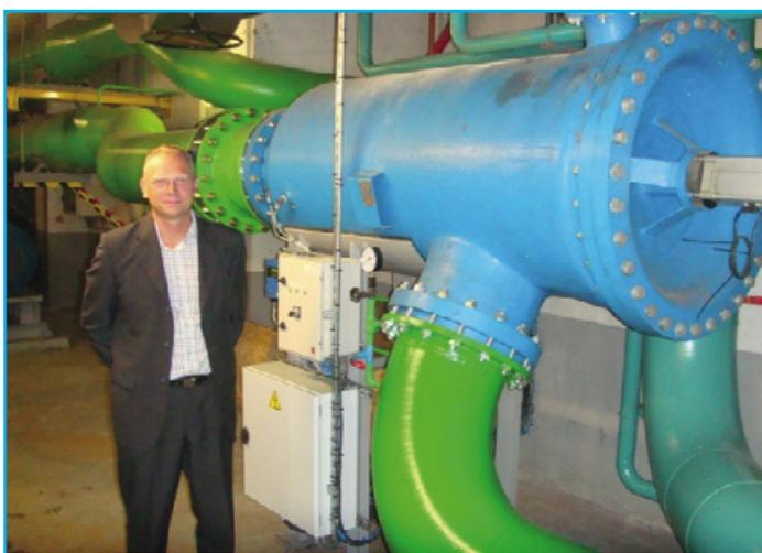
Une équipe d'ingénieurs suédois confrontés aux problèmes d'encrassement et de colmatage d'échangeurs thermiques (échangeurs à plaques) s'est penché sur l'étude d'un système de filtration à la fin des années 1980. Leur idée consistait à exploiter un principe connu en mécanique des fluides : le « Principe de Bernoulli »\*. Aussi, les ingénieurs sont parvenus à mettre au point des filtres utilisant la puissance de ce phénomène naturel pour effectuer une filtration efficace.
