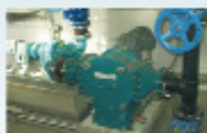
Le Multichopper Börger est un broyeur à grille et à couteaux. Les 3 couteaux assurent une coupe idéale à chaque rotation.
