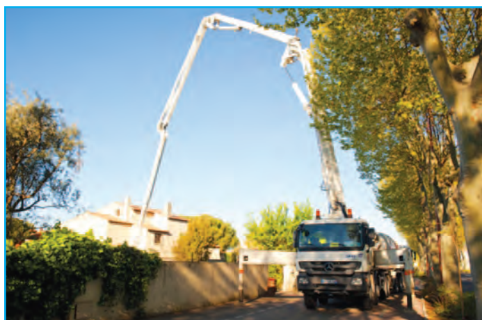
Les premiers utilisateurs du pompage du béton sont les producteurs de BPE (Béton Prêt à l'emploi).
