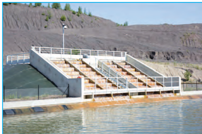
La cascade d'oxygénation des eaux d'un bassin de décantation
