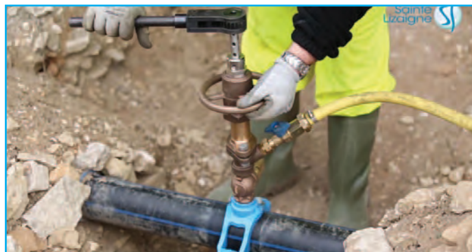
Mise en place d'un raccordement Sainte-Lizaigne sur une tuyauterie sous pression. L'ensemble devra tenir sans fuites pendant plusieurs dizaines d'années...
