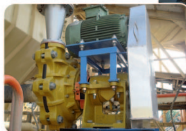
EMW-R : Pompe à blindage caoutchouc
