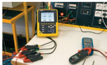
Le centre de formation Chauvin Arnoux est en plein Paris.
