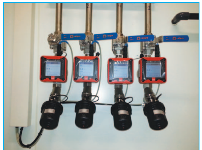
Ces compteurs permettent à LUTZ de réaliser des ensembles de dosage automatisés
