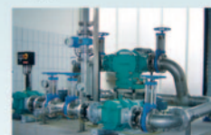
Le Multichopper Börger est un broyeur à grille et à couteaux. Les 3 couteaux assurent une coupe idéale à chaque rotation.
