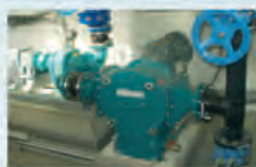
Le Multichopper Börger est un broyeur à grille et à couteaux. Les 3 couteaux assurent une coupe idéale à chaque rotation.
