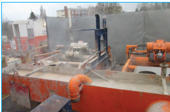
Les boues de forage circulent en circuit fermé.
