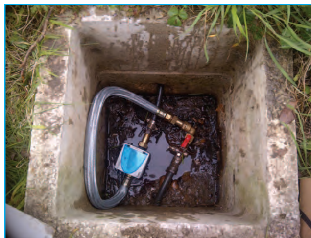
Le SENSUS iPERL en fonctionnement (photo du constructeur)
