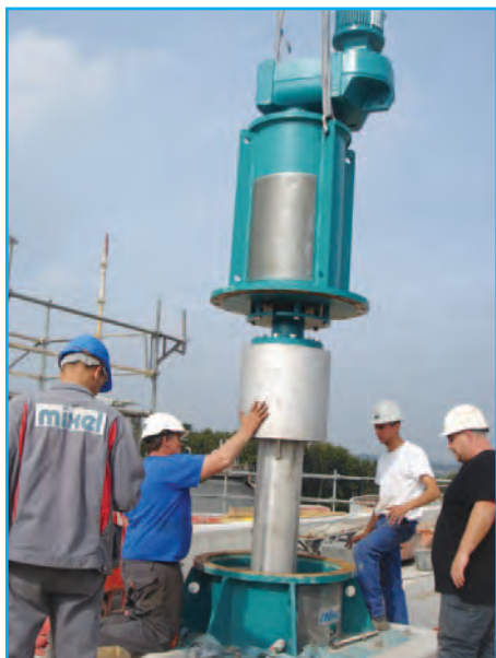
DIGIMIX en cours d'installation
