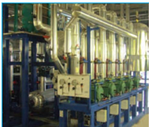
L'utilisation du CO<sub>2</sub> en frigoroporteur permet de faire fonctionner l'installation de réfrigération à une température d'évaporation plus élevée que sur une installation classique. Selon les spécialistes de ce domaine, la consommation énergétique des compresseurs frigorifiques en est réduite de plus de 10 % !
