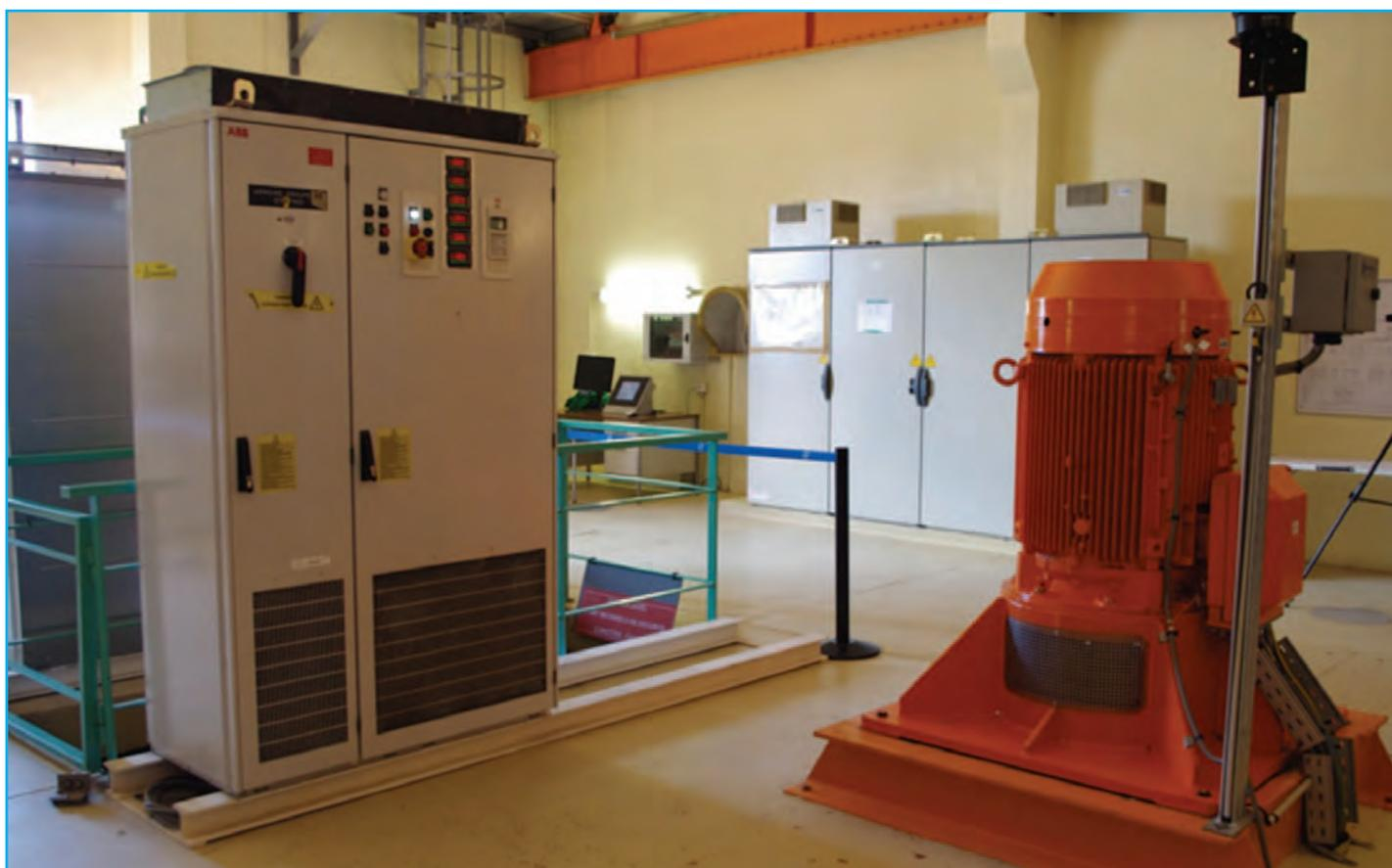
Le moteur et l'armoire de commande de l'une des nouvelles pompes à vitesse variable à la station Noisy 2
