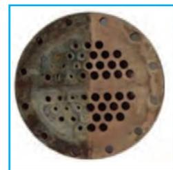
Photos d'entrée d'un échangeur tubulaire non protégé par filtration avant et après nettoyage
