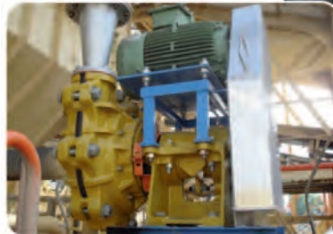
/ EMW-R : Pompe à blindage caoutchouc
