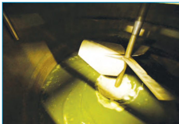
Intérieur d'une cuve de traitement des algues
