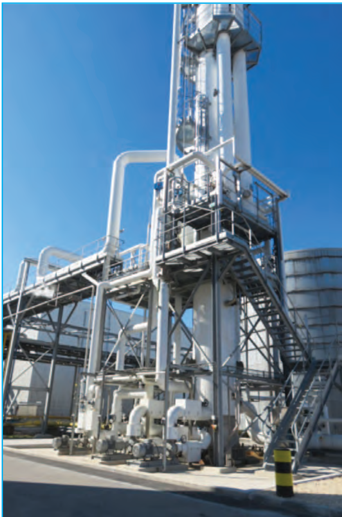
Côté TEREOS : vue en pied de l'échangeur DEDERT et des groupes de pompe qui font circuler l'eau chaude produite dans l'usine
