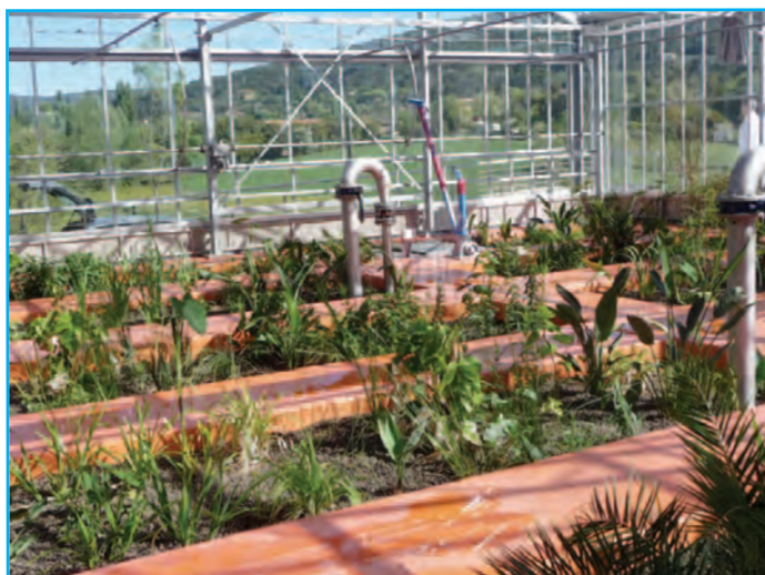
Une très belle station d'épuration qui s'inscrit parfaitement dans le paysage
