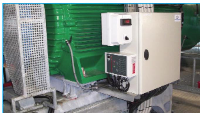
Equipement d'un moteur de télésiège
