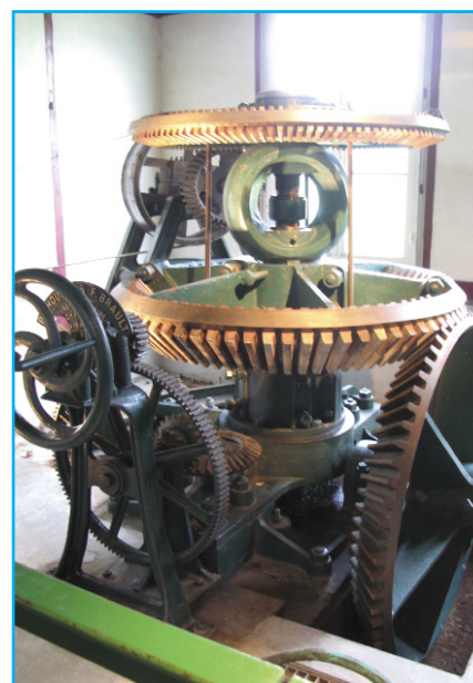
Vue extérieure de la turbine qui entraîne les nouvelles pompes. On remarque les engrenages bois-métal qui permettaient d'avoir des pièces d'usure faciles à remplacer. Quel génie !
