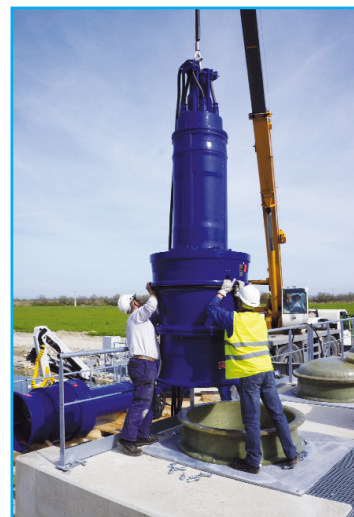
Mise en place de l'une des 13 pompes Amacan fournies par KSB.
