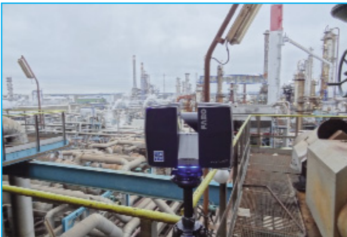
Scanner en place sur un site
