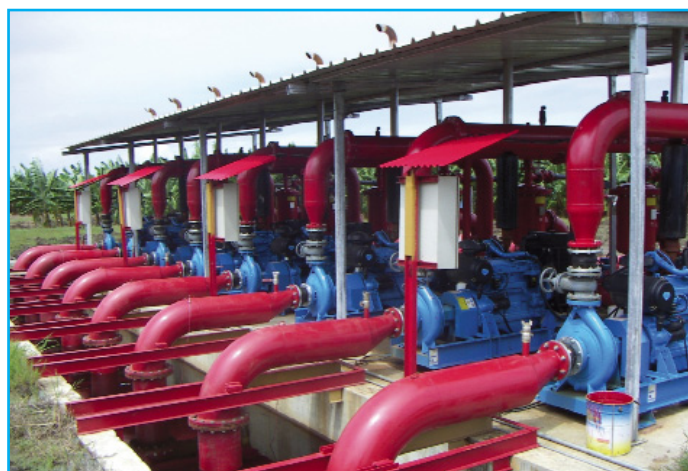
Une station d'exhaure réalisée avec des motopompes produits par 2 Garení Industrie
