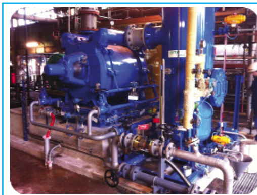
Vue générale installation de vide et vue du suivi vibratoire
