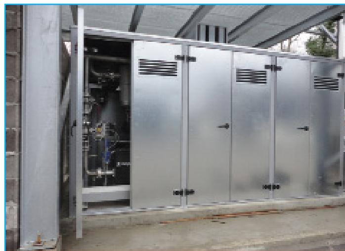
compresseurs pour le brassage de digesteur ou de Booster pour assurer l'alimentation en Biogaz de chaudières ou de torchères.
