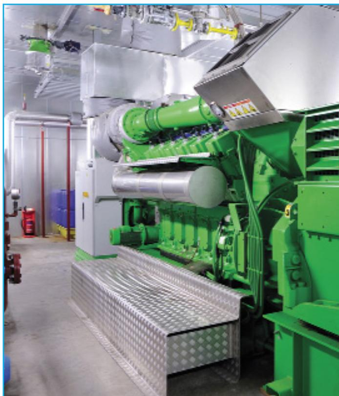
thermique (cogénération). Les moteurs à gaz à alimentation par biogaz valorisent ainsi la gestion des déchets tout en maximisant la rentabilité de la production d'énergie.
