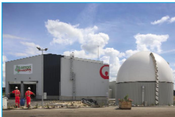
site, soit une économie de 70 000 litres de fuel par an. Puis, le résidu de la fermentation du biogaz appelé digestat est hygiénisé (5) (à 70 °C pendant une heure) avant d'être déshydraté en centrifugeuse. La fraction solide du digestat (soit 7 000 t/an) rejoint le site voisin de compostage de boues d'épuration afin d'être revendu sous forme de fertilisant aux agriculteurs de la région.
